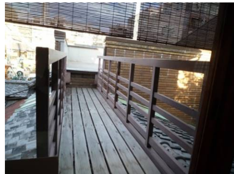
写真4 鉾見台へ渡る廊下
