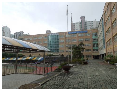
図2 ベイル初等学校の校舎
