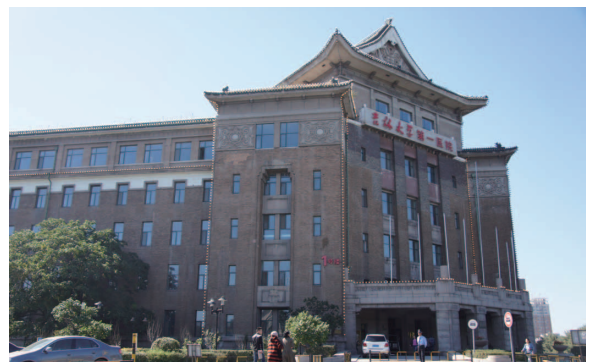
写真5 吉林大学第一医院(満州時代の軍事部)のメインビルディング 1935年に竣工したこの建物は、その様式が現在の附属京都小学校の本館(1938年竣工)と類似している。この時代に流行した帝冠様式(日本古典様式と西洋古典様式の折衷)というデザインを基調にしているように見える。この建物の屋根末端は、反り上がっており、中国古典様式も付与されている。こうしたものは、興亜帝冠様式と呼ばれることもあるようだ。(2013年9月26日、香川貴志撮影)
