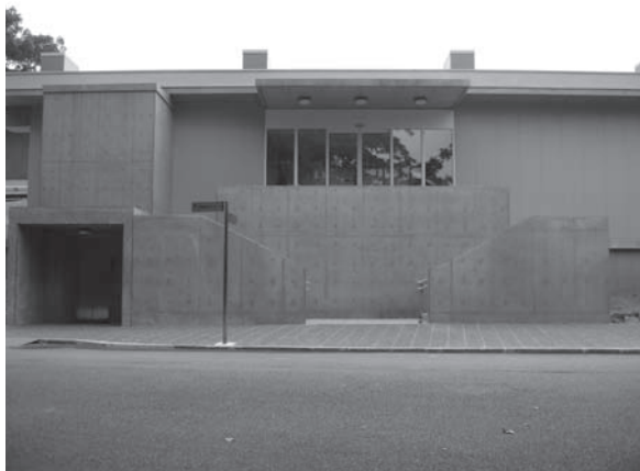
写真1 道路側から増築建物正面
