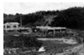
新校舎工事風景（昭和46年）
