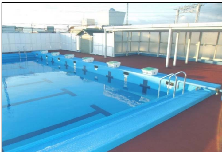
図 3. 附属桃山中学校プール北側
