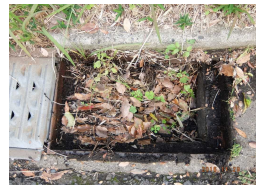
本部署倉庫キュービクル道路前の排水溝の汚泥・木の根等の除去清掃
