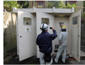
講堂奥キュービクル・図書館電気室の高圧トランスの表面温度の測定
