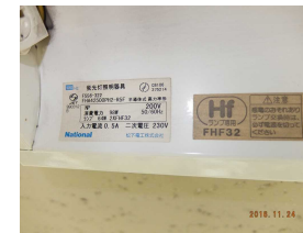
附属学校 支援課事務所蛍光灯2灯式安定器不良及び型番
