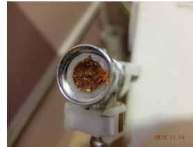
トレーニングセンター多目的トイレ給水タンクの水量が少ない修理
