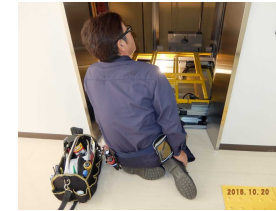
エレベーター点検立会い
