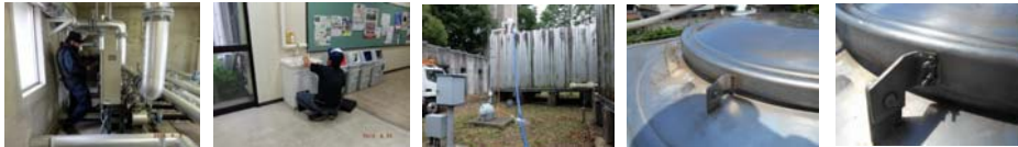
送水設備点検状況 水質検査(採水)状況 受水槽清掃状況 受水槽マンホール蓋固定金具不良状況 受水槽マンホール蓋固定金具是正完了
