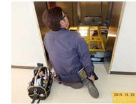
エレベーター点検立会い
