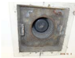
課外活動施設文系男女トイレ換気扇のカバー外し清掃
