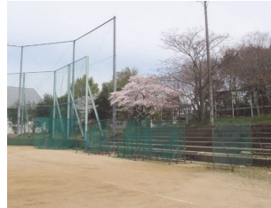
スタンド前に防球ネットが無く、移動式のもので対応しているが、高さが足りない
