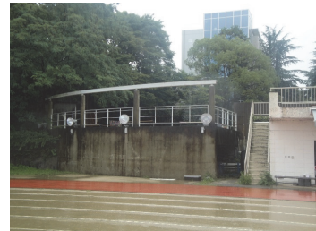
安全支障がある照明設備を学内費で整備
