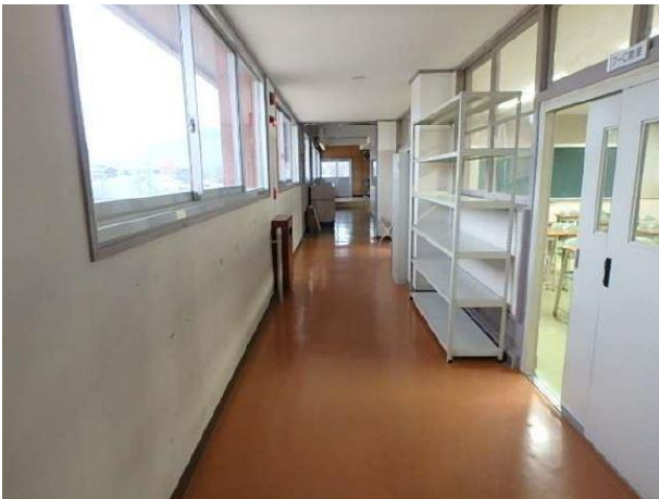
附属京都小中学校廊下改修
